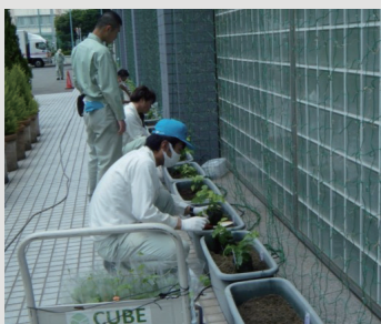
本社グリーンカーテン設置作業の様子
