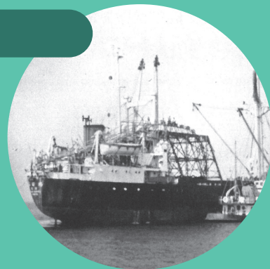
アラビア石油海底油田用ケーブル敷設作業（昭和37年）
