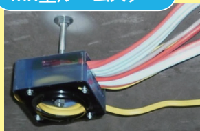
● 図2: MX型ルームスターの施工例
